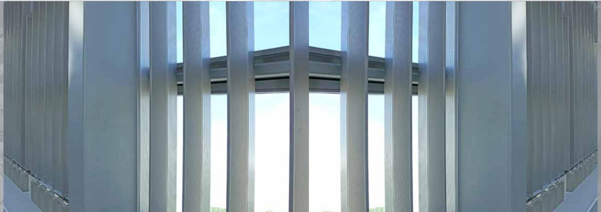
Beispiel einer Deckenkonstruktion aus Lochblechen die im Wassertransferdruck beschichtet wurden.
